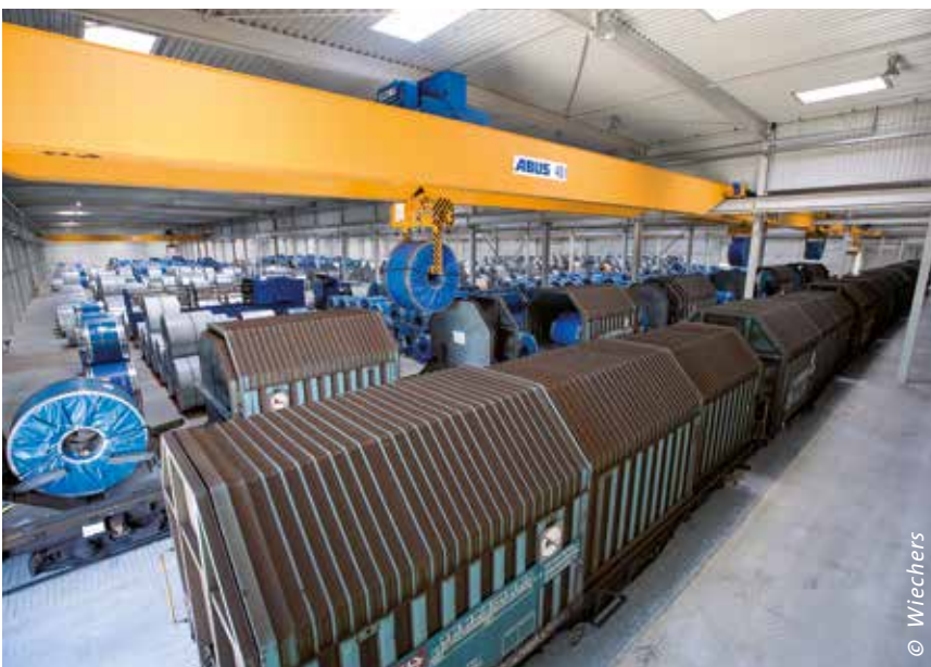
Be- und Entladung von Ganzzügen auf 250 m gedeckter Gleisanlage.
