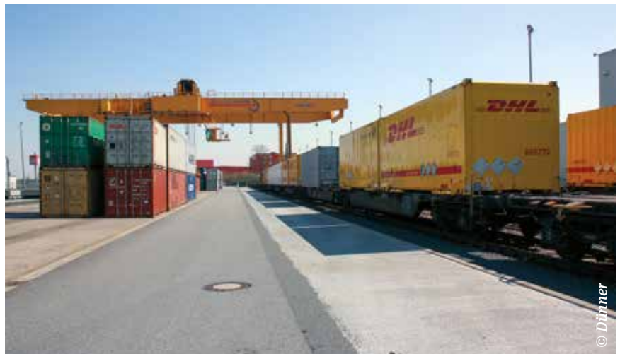
Das Logistikzentrum RuhrOst (LZR) in Bönen fungiert als zentrale Schnittstelle zwischen West- und Nordhäfen. Es verfügt über vier 550 Meter lange Ladegleise, die von zwei Portalkränen bedient werden.
