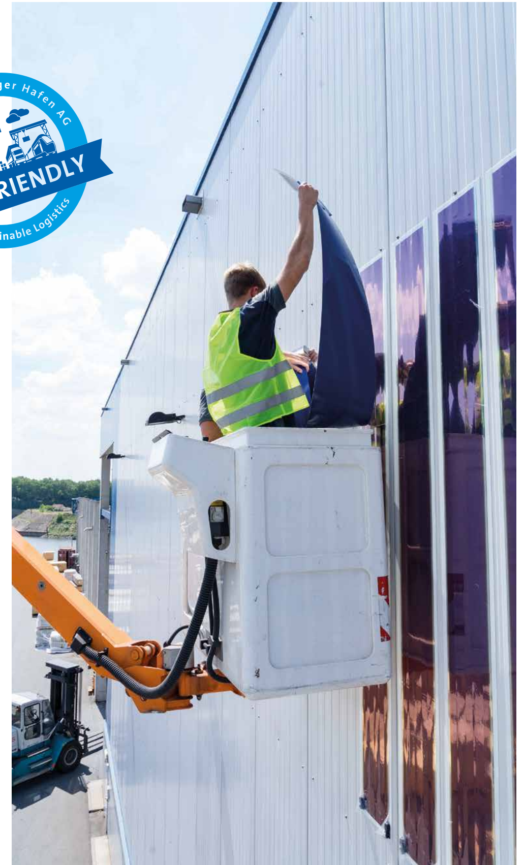
Die organischen Solarfolien wurden auf einer 200 Quadratmeter großen Hallenfassade im Freihafen angebracht.
